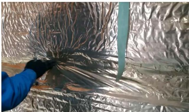
Figure 35 : adhésif maroufflé sur l'isolant
